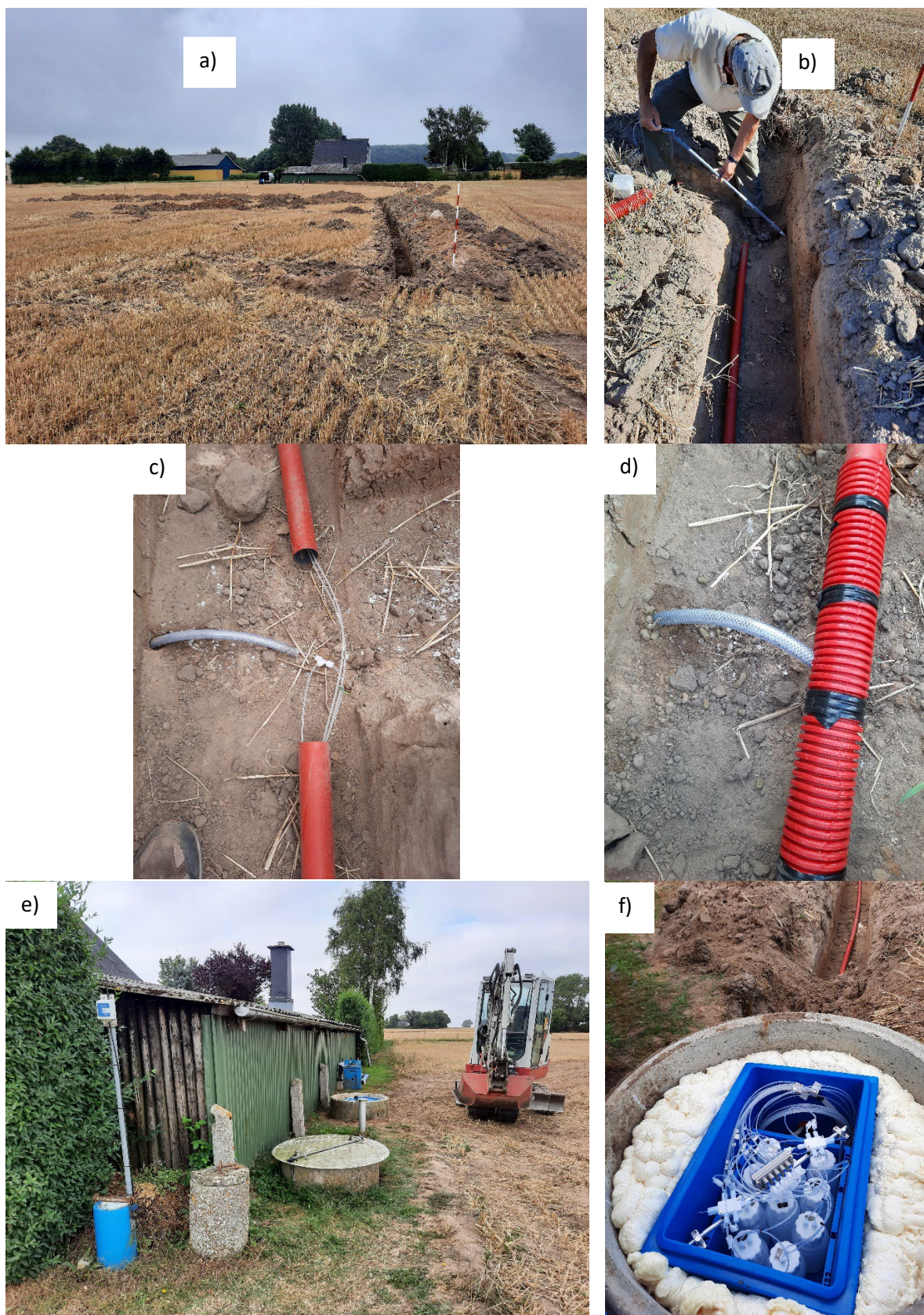
Figur 4. a) opgravet rende, b) installation af sugecelle, c) samling af sugecelleslanger med T-stykke til udluftningsslange, d) beskyttelsesrør monteret, e) fjerneste cementring er placering af ny opsamlingsbrønd, nærmeste cementring med aluminiumslåg er eksisterende brønd, f) ny opsamlingsbrønd med flasker i termokasse og isolering, øverst i billedet ses orange beskyttelsesrør i rende
