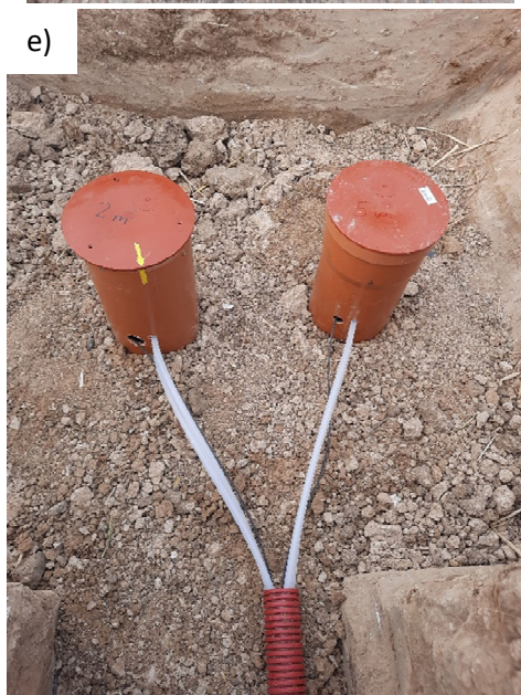
Figur 6. a) boring af peijlerør, b) de to peijlerør, c) gruslag ved peijlerør, d) peijlerør med topprop, beskyttelsesbrønd, udluftningsslanger og kabel fra datalogger til opsamlingsbrønd, e) beskyttelsesbrønd, udluftningsslanger og kabel til logger, f) opsamlingsbrønd: udlæsning af data fra dataloggere
