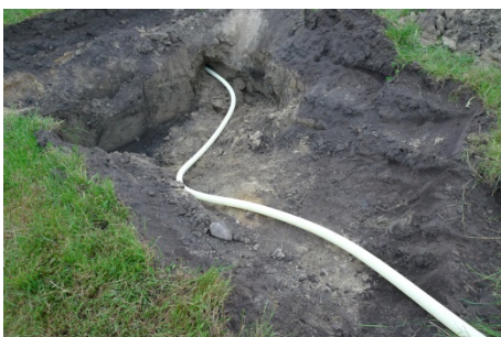
Udgravningen hvor rør og slanger er skudt ud.
