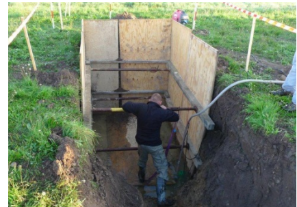
Afstivning i udgravning hvorfra der "bores". Foto fra en tidligere udført horisontal boring.
