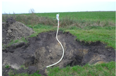
Markskellet hvor målebrønden etableres.
