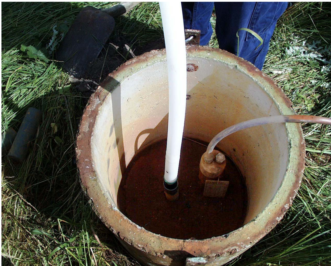
Fig. F: Slangen skubbes ned i det oprindelige rør.
