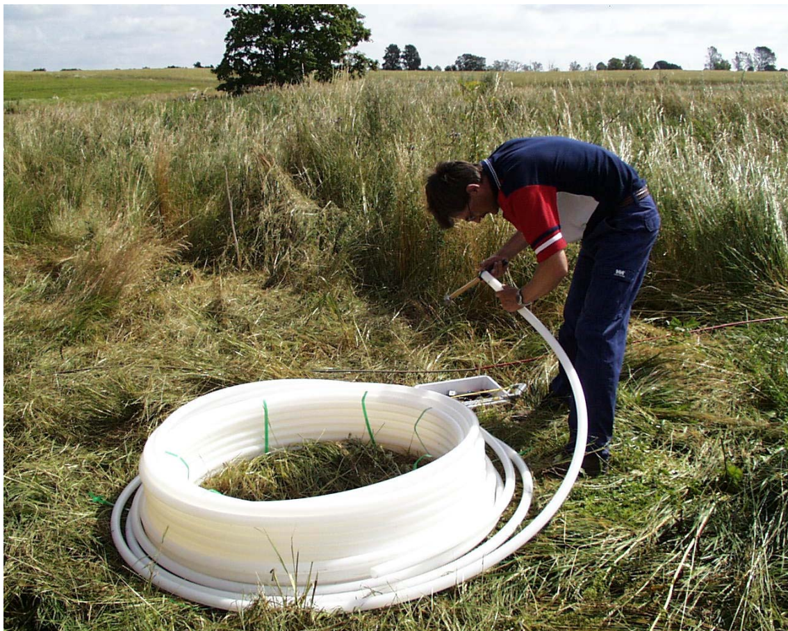
Fig. D: Endeløst PEM rør – montering af ny kugleventil
