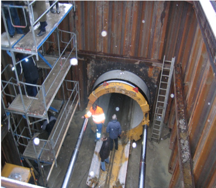
Figur 6. 2500 mm Ø kloakledning, som etableres ved hjælp af "no-dig" i et dybt skakt-system.
