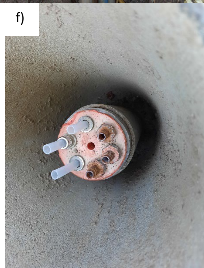
Figur 1. a) prøveudtagningsbrønd, cemenrør, b) beskyttelsesrør i bund af rende, c) defekte prøvetagnings-slangers, d) prøvetagnings-slangers repareret, e) gamle porøse pvc-rør i prøvetagningsbrønd, f) nye PE-slangers i prøvetagningsbrønd
