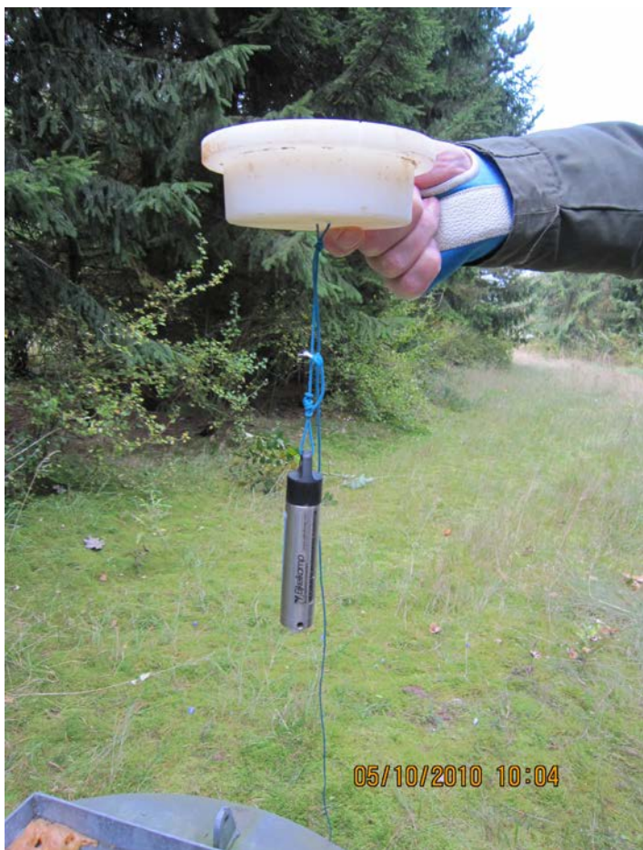
Figur 5. Barodiver ophængt i toppen af boring over vandspejlet, for måling af lufttryk. Den bør dog hænge mindst 3 m.u.t for at sikre frostfrie forhold. Hvis loggeren monteres på denne måde, skal man huske at lave hul i låget, så der er mulighed for trykudligning mellem boring og atmosfæren. For at minimere påvirkningen fra vindbåren forurening og nedbør, skal hullet være mindst muligt og placeret under hensyntagen til forureningsrisikoen.
