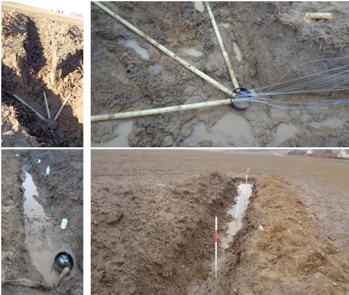
Figur 2-6. Billeder fra etablering af sugecellefelter i december 2015 og februar/marts 2016
